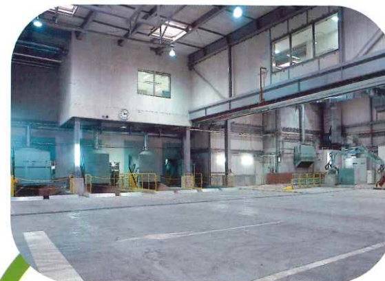
リサイクルプラザ プラットホーム
