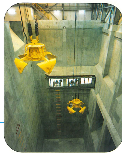
ごみクレーン
