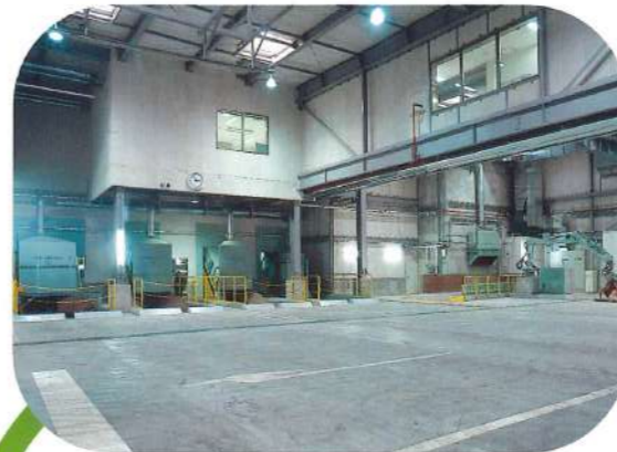
リサイクルプラザ プラットホーム
